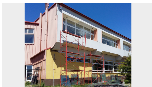
Durante el mejoramiento de la envolvente térmica de la Escuela Baquedano
