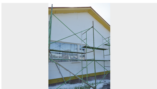
Escuela Baquedano, durante la implementación de la aislación exterior EIFS
